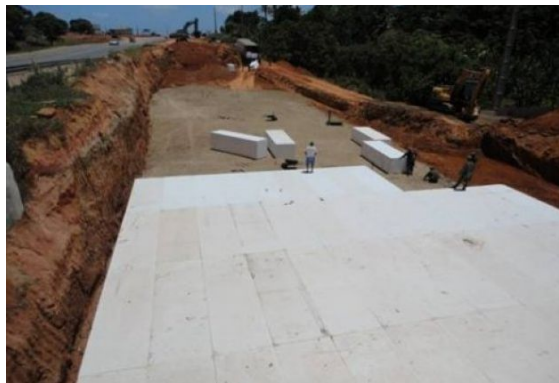
Figura 10 –Aplicação de blocos de EPS como metodologia de aterramento
