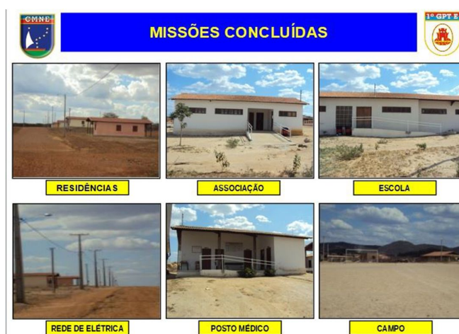
Figura 13 – Instalações feitas pelo 1º Gpt E
