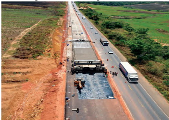
Figura 9 - Obras em execução da adequação da BR-101 às necessidades operativas do transporte nacional
