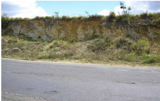
Figura 5 -Pista sem sinalização e com buracos
